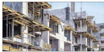
नागणी आता 'नरेडको'चे केली आहे. गृहप्रकल्पाच्या प्रत्येक कामासाठी पाण्याची आवश्यकता आहे. पाणीपुरवठ्यावर काम पूर्णतः अवरुद्ध आहे. असे असताना जर आता बांधकामाला पाणीच उपलब्ध होणार नसल्याने आणि ही परिस्थिती दीर्घकाळ रहिल्यास प्रकल्पचे वेळापत्रक कोलमडेल. खर्च वाढेल, कामगारांची उत्पादकता घटेल आणि घरांचा ताबा देण्यास विलंब होईल, अशी शक्यता नरेडको महाराष्ट्रचे अध्यक्ष कमलेश ठाकूर यांनी व्यक्त केली.
